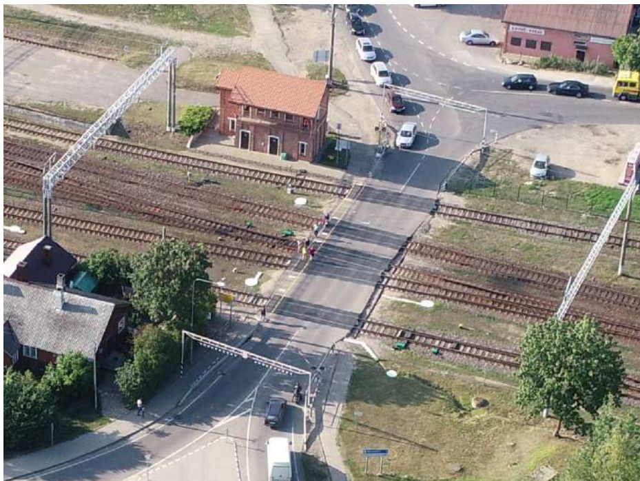
1 pav. Esama geležinkelio pervaža
