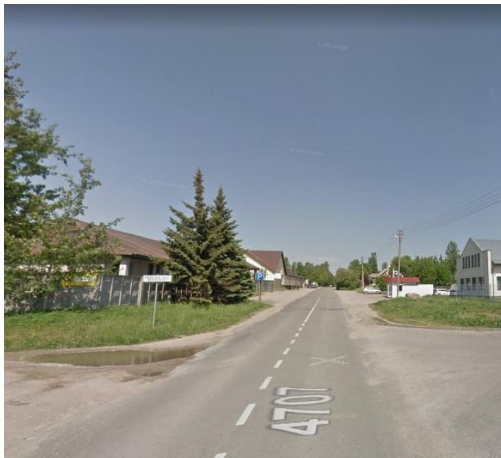
2.1 pav. Esamos situacijos fotofiksacija Fabriko gatvėje
